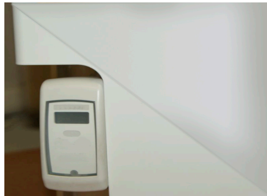
Рисунок 6-22. Счётчик-распределитель на конвекторе
