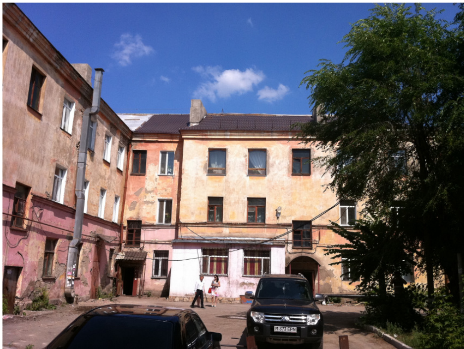
Фасад дома со стороны двора / частично обновлённые пластиковые окна
