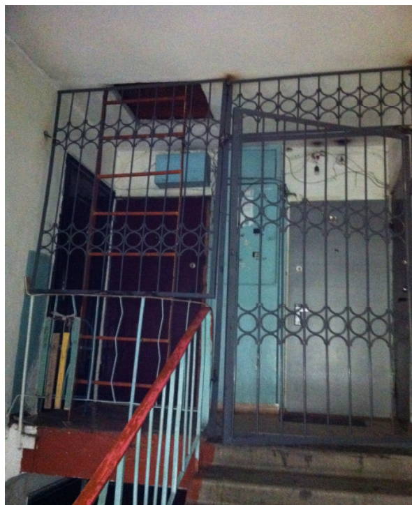
Фрагмент лестничного проёма и лестничной клетки
