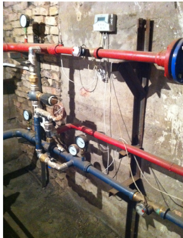
Дистанционное измерительное устройство для поступающей горячей воды и её оттока
