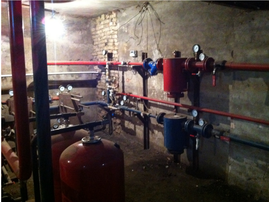
Новый тепловой пункт с дистанционным управлением (учёт измерительных данных на основе радиосвязи)
