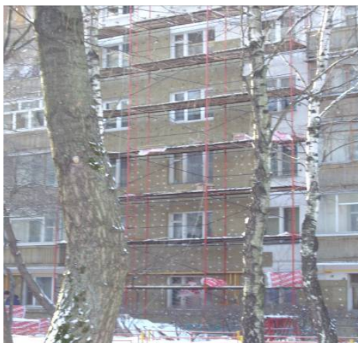
Процесс ремонта. Установка навесной теплоизоляции
