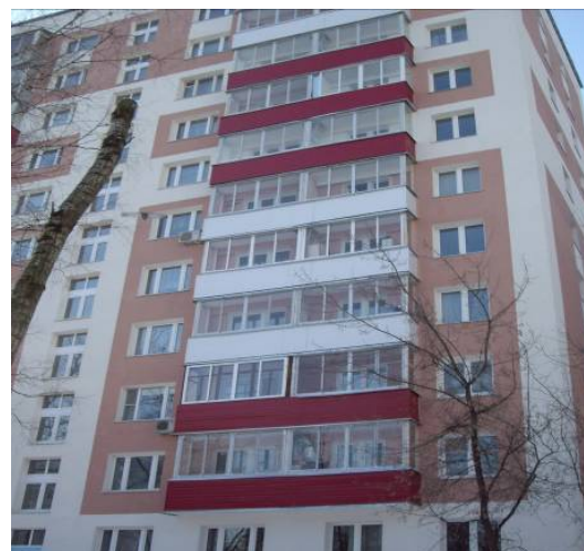
Результат ремонта. Установлены пластиковые окна, навесная теплоизоляция, остеклены лоджии
