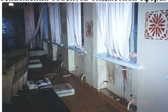
«Замороженная» система отопления интерната в пос. Оротукан Магаданской области
